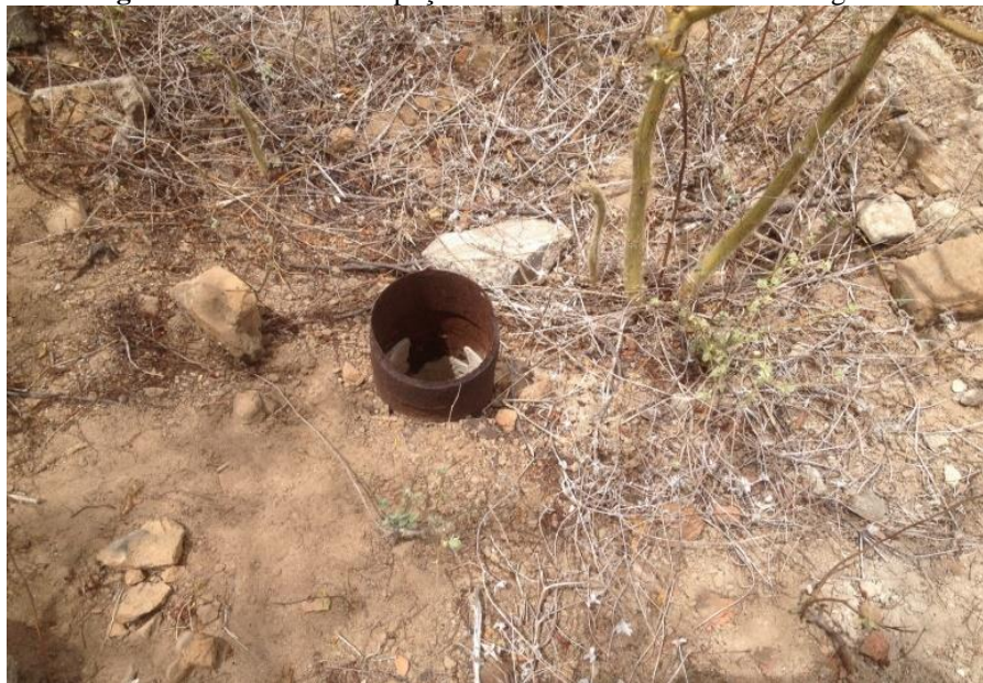
Figura 3.58 - Detalhe do poço existente na Comunidade Camagaribe.
