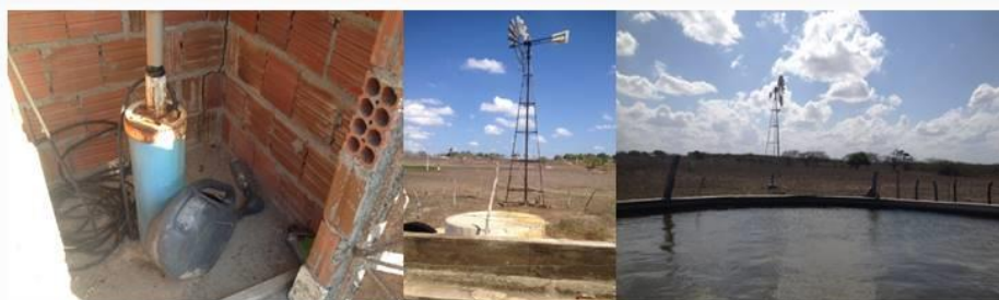
Figura 2. Poços existentes em Jurumenha (seis particulares e cinco públicos). Fonte: Equipe de elaboração do PMSB/UFRN, 2017.
