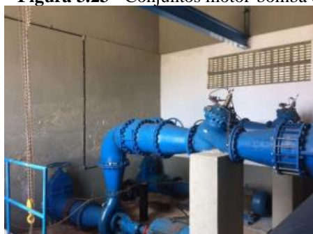
Figura 3.23 - Conjuntos motor-bomba da estação de bombeamento de Boa Cica (EB 00) (a e b)
