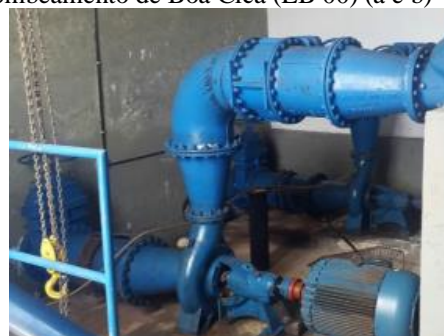
Figura 3.23 - Conjuntos motor-bomba da estação de bombeamento de Boa Cica (EB 00) (a e b)
