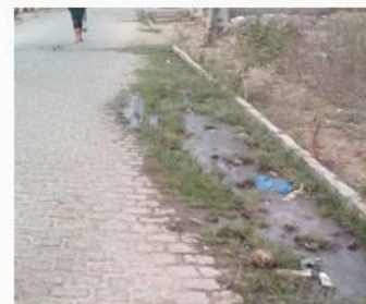
Figura 6. Disposição de águas cinzas em vias públicas. Fonte: Comitê Executivo do PMSB de Santa Maria, 2017.
