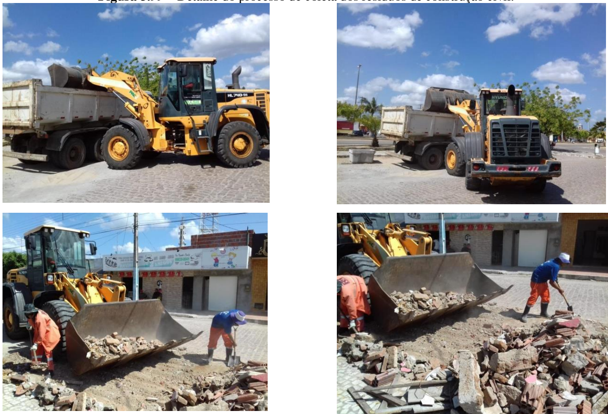
Figura 3.99 – Detalhe do processo de coleta dos resíduos de construção civil.
