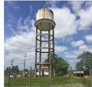
Figura 4. Reservatório elevado de Santa Maria. Fonte: Comitê Executivo do PMSB de Santa Maria, 2017.
