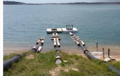
Figura 1. Sistema de captação flutuante na Lagoa do Bonfim. Fonte: Equipe de elaboração do PMSB/UFRN, 2017.
