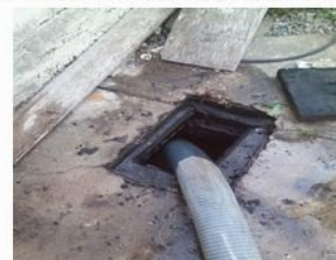
Figura 10. Fossa passando pelo processo de esgotamento sanitário. Fonte: Comitê Executivo do PMSB de Santa Maria, 2017.
