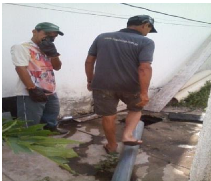
Figura 3.80 - Funcionários realizando a limpeza de uma fossa rudimentar.
