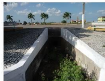
Figura 15. Galeria de água pluvial existente na Avenida Presidente Juscelino. Fonte: Comitê Executivo do PMSB de Santa Maria, 2017.
