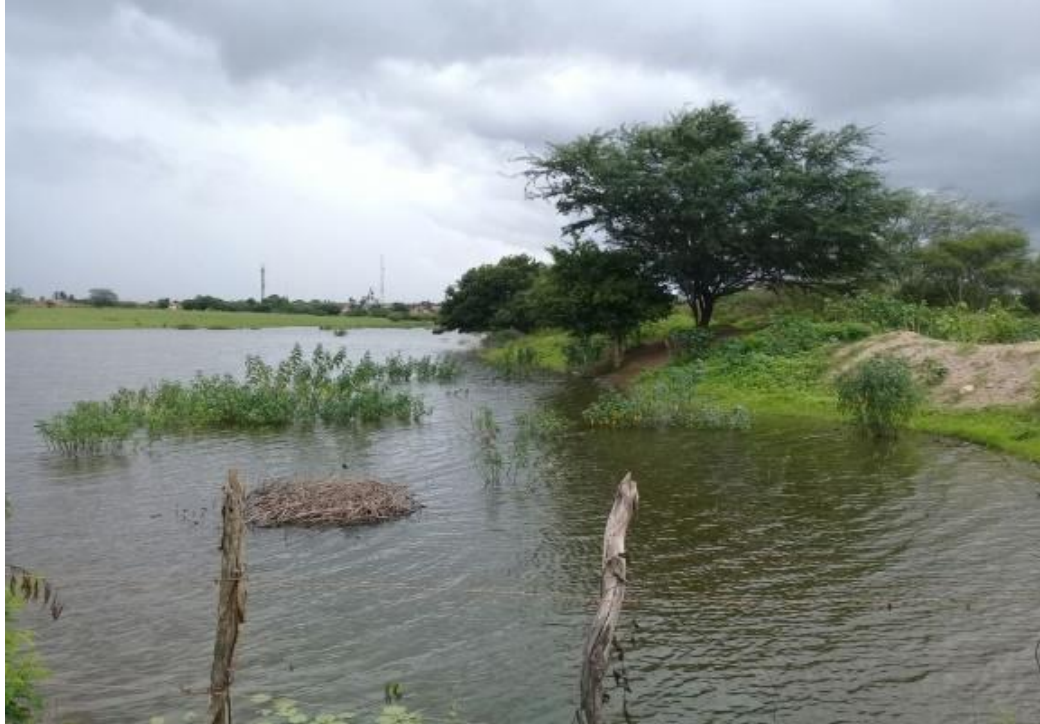
Figura 3.122 – Detalhe do açude onde as águas pluviais coletadas pelo sistema de drenagem são destinadas.
