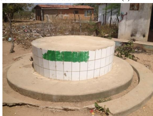
Figura 3.52 - Detalhes da área do dessalinizador na Comunidade Caiçara: Local onde funcionava o sistema de dessalinização (a), Detalhe do apoio utilizado para inserção do reservatório elevado da água para armazenamento da água oriunda do dessalinizador (b) e Detalhe do local onde ficava o dessalinizador (c).
