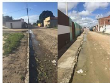
Figura 19. Lançamento de esgoto no sistema de drenagem da zona urbana de Santa Maria. Fonte: Comitê Executivo do PMSB de Santa Maria, 2017.
